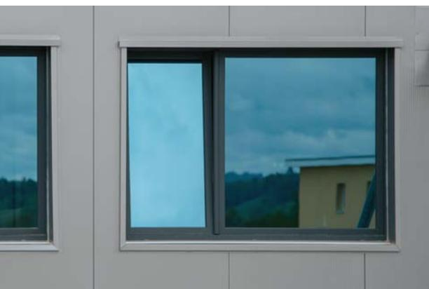
Mit dem Profilsystem VEKA SOFTLINE 82 MD wurden Fenster in Normalgrösse und auch in Schaufenstergösse (3 x 2 m) hergestellt. Die Hebeschiebetüren sind stufenlos, die Fenster in der Getränkehalle mit Sonnenschutzglas ausgestattet.
